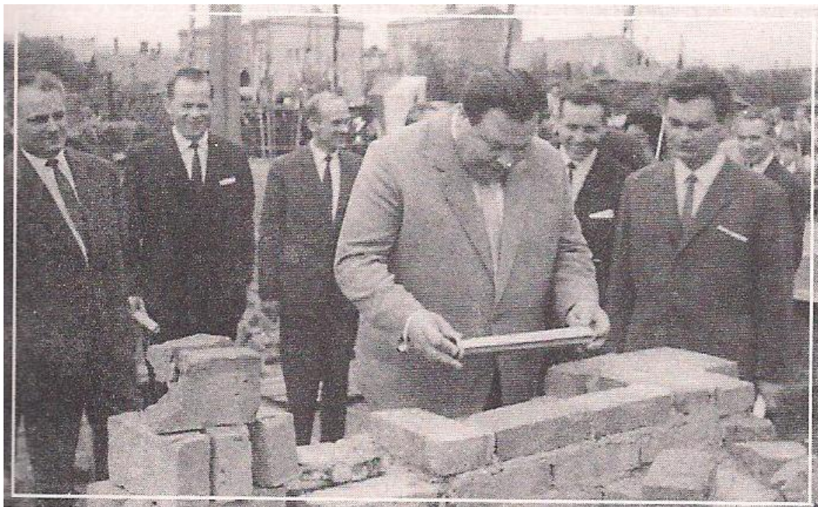
Wmurowanie aktu erekcyjnego (zdjęcie powyżej).
